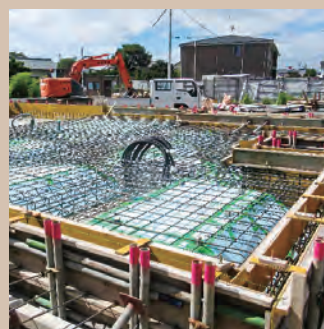
建設工事(9/14現在・基礎部工事)
