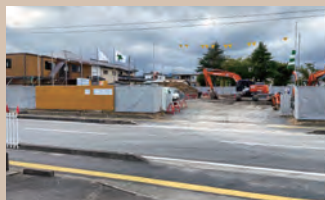
建設工事(9/16現在・基礎部工事)
